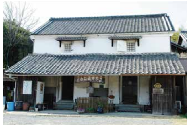
木綿蔵・ちた 平成26年文化財建造物指定
